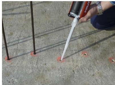
Injizieren eines geeigneten Injektionsmörtels für nachträgliche Bewehrungsanschlüsse gemäss Vorschriften des jeweiligen Lieferanten. Einschlagen der Armierungsstäbe.
