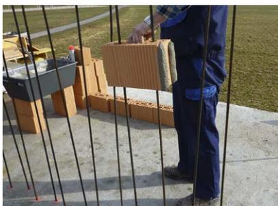
Einfädeln des Steines mit aufgebrachtem Stossfugenmörtel (Spatz).
