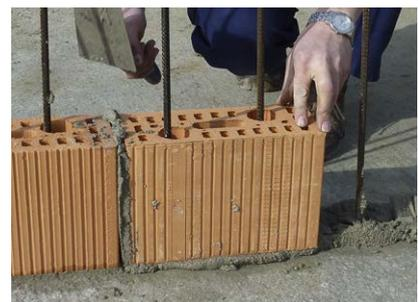
Das Mauerwerk muss vollfugig erstellt werden.
