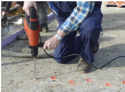
Trockenes Auslegen der Steine, markieren der Lochungen. Anordnung der Bewehrungsstäbe gemäss Angaben des Ingenieurs. Bohren der Löcher in Beton, Bohrlöcher gut ausbürsten und ausblasen.
