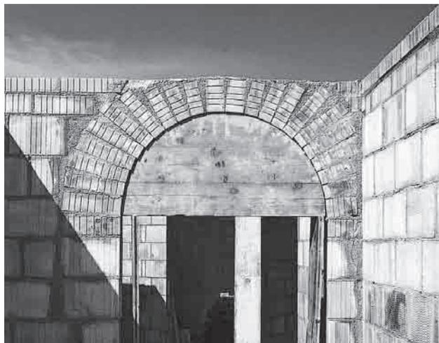
Dank dem Einsatz von Backsteinen mit erhöhter Druckfestigkeit konnte bei diesem Rundbogen eine Mischbauweise vermieden werden. Der Verband mit SwissModul Backsteinen ist deutlich sichtbar.
