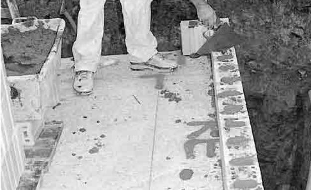
In der ersten Lage Murfor® RE wird Mörtel verfüllt. Da der Entscheid für Murfor® RE erst nach dem Betonieren der Decke fiel, ist das RE Mauerwerk mit eingebohrten Bewehrungsseisen in die Betondecke verankert worden. Normalerweise wird die Einspannung in die Betondecke mit dem Anschlusskorb RE 53/15 A ausgeführt.
