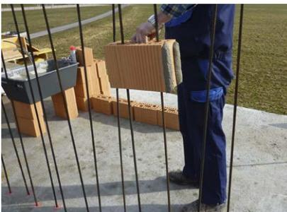
Einfädeln des Steines mit aufgebrachtem Stossfugenmörtel (Spatz).
