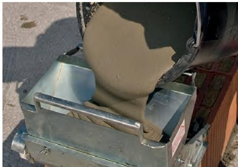
Der angerührte Dünnbettmörtel wird in die Mörtelrolle/-schlitten gefüllt. Damit wird der Mörtel rationell und einfach aufgetragen.
