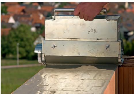
Die Mörtelrolle/-schlitten deckelt in einem Arbeitsgang die Lagerfuge vollflächig mit Dünnbettmörtel.
