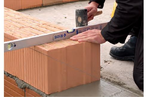
Die erste Lage «ThermoCellit®» wird auf das exakt abgezogene Mörtelband gesetzt und mit der Wasserwaage und dem Gummihammer feinjustiert.
