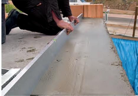
Um Unebenheiten der Bodenplatte auszugleichen, wird der Ansetzmörtel M10, aus Kimmschichtmörtel mit Anlegetfix und Alulatte massgenau angelegt und abgezogen.
