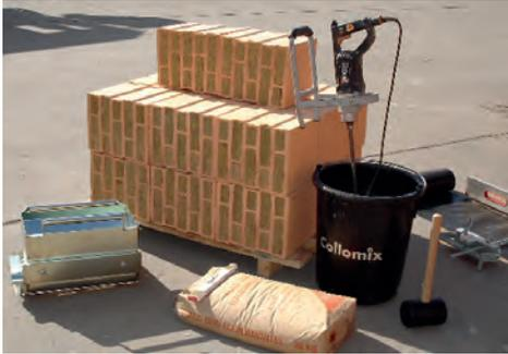
Benötigtes Material: Mörtelrolle/-schlitten, 30 Liter-Mischeimer, Rührwerk mit Doppelspindel, Ansetzmörtel M10, Anlegetfix, Zahntraufel Breite 28 cm, Zahnung 6 mm, Gipsrpfännchen gross und Gummihammer.
