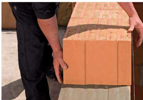
Jetzt werden die Steine aufgesetzt und mit dem Gummihammer ausgerichtet. Fertig!
