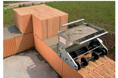
Mörtelrolle/-schlitten fortlaufend in eine Richtung ziehen (siehe Beschriftung am Gerät), dabei die Laufrollen auf die untere Ziegellage drücken.
