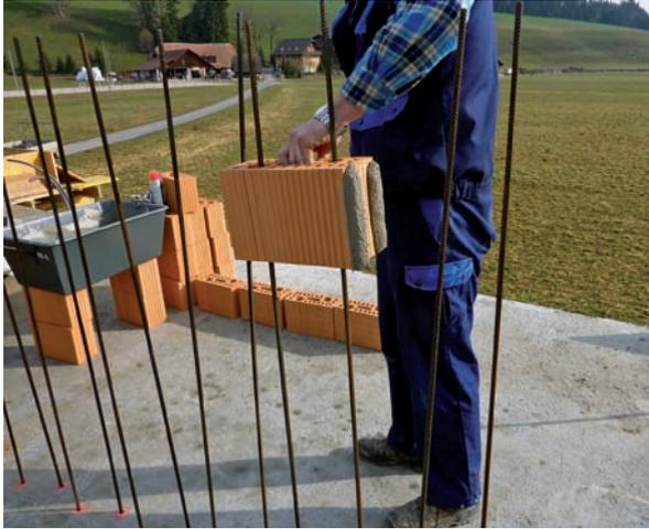
4. Einfädeln des Steines mit aufgebrachtem Stossfugenmörtel (Spatz).
