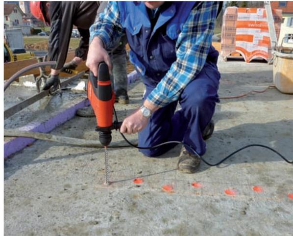
1. Trockenes Auslegen der Steine, markieren der Lo- chungen. Anordnung der Bewehrungsstäbe gemäss Angaben des Ingenieurs. Bohren der Löcher in Beton, Bohrlöcher gut ausbürsten und ausblasen.
