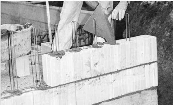
Anschliessend werden die Löcher mit Mörtel verfüllt.
