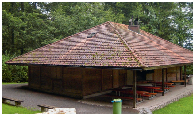
Dach vor der Behandlung mit Abbamousses
