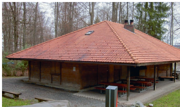
Dach nach der Behandlung mit Abbamousses
