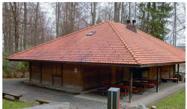
Dach nach der Behandlung mit Abbamousses
