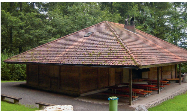
Dach vor der Behandlung mit Abbamousses
